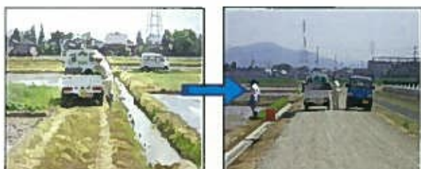
2～3m幅の農道を5m幅に整備
