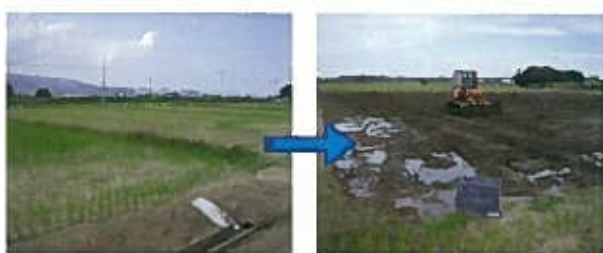
H24年12月に竣工した石沢地区 (畦を撤去し、ブルドーザにて整地して区画拡大)
