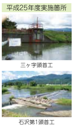
石沢第1頭首工
