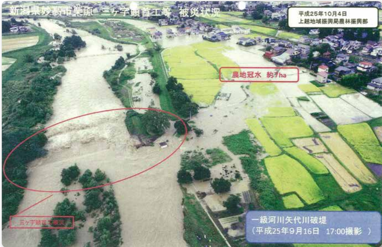
矢代川右岸堤防が破堤（妙高市栗原地内）
