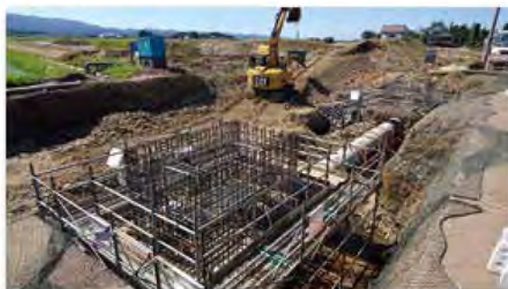
木島宇経塚地内の用水サイホン施工状況
