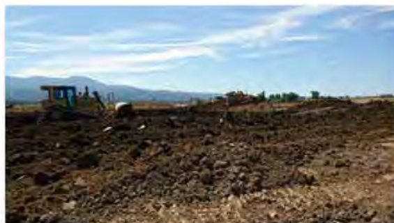
木島宇経塚地内の整地状況
