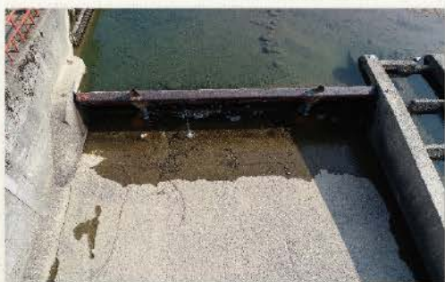
三ヶ字頭首工(工事前)
