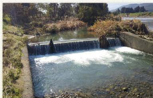
石沢第1頭首工(工事前)
