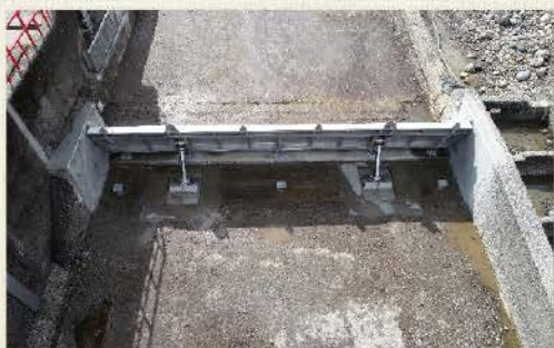
三ヶ字頭首工(竣工)
