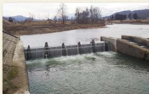
石沢第1頭首工(竣工)
