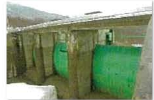
洪水吐ゲートの全面塗装
