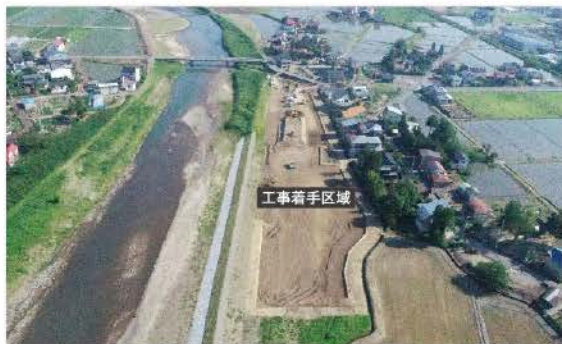
面工事が開始された石沢地区(西田中地内)
