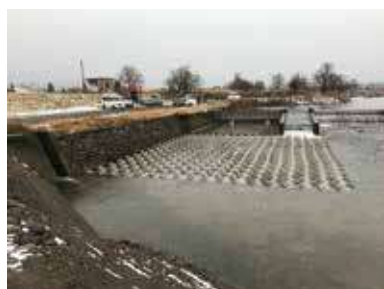
柳井田頭首工
