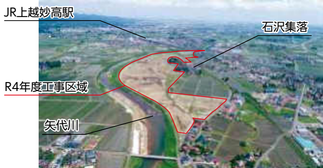
▲石沢地区の面工事の様子
