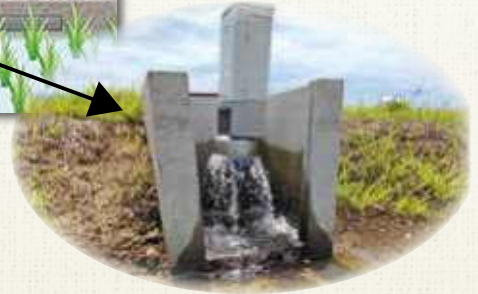
遠隔型自動給水栓 ▼※先進地高野地区で撮影
