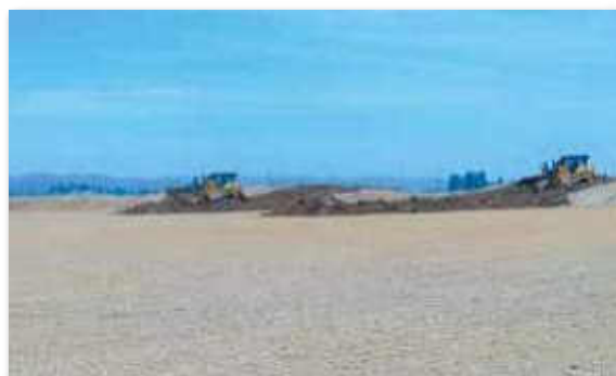
▲島田地区 整地状況
